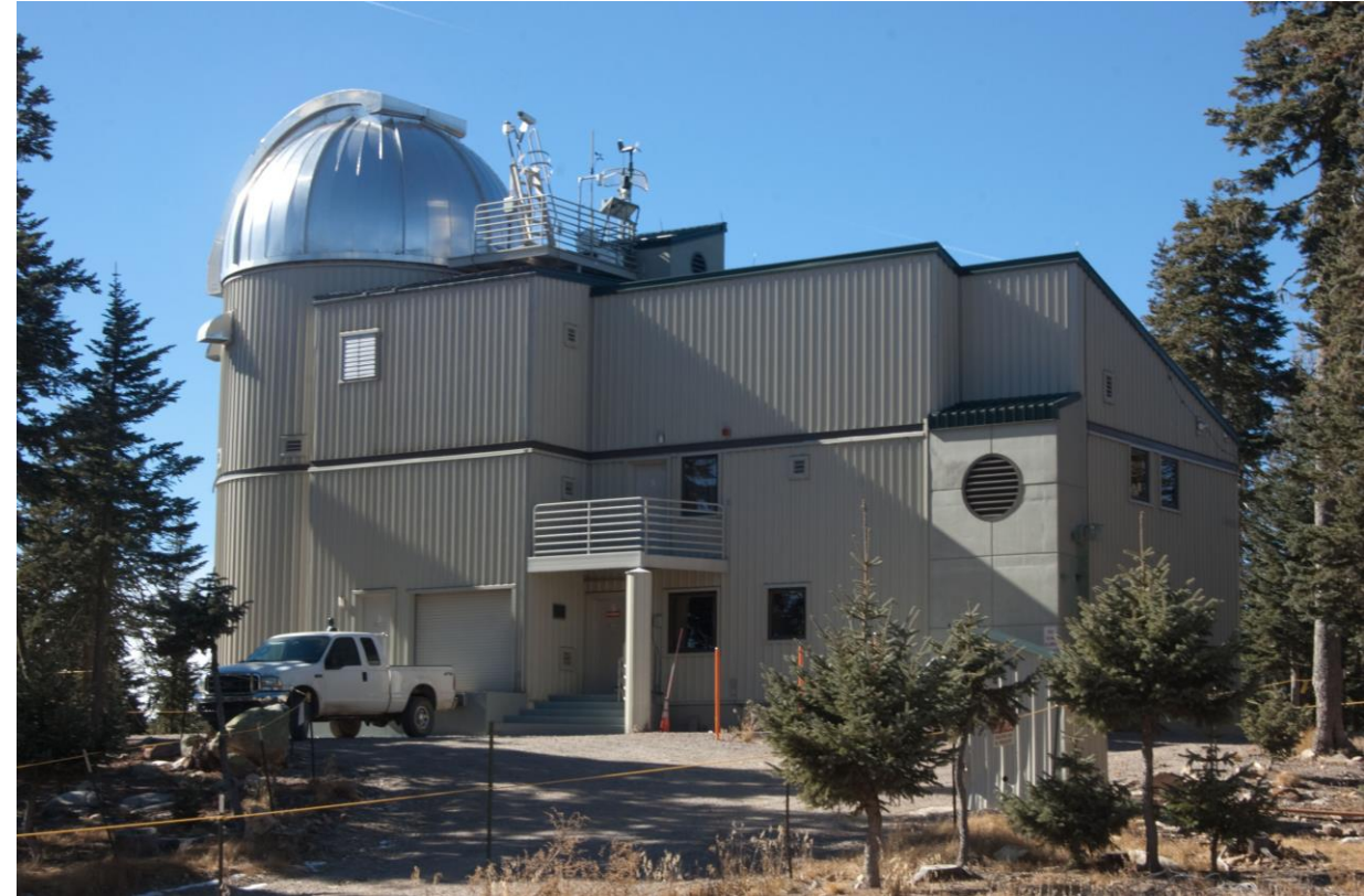
Ab 1993: Vatican Advanced Technology Telescope (VATT), Mount Graham 3,178 m, Safford, Arizona, USA. Teleskoptyp: Gregory Öffnung: 1.8m Brennweite: 16.48m
